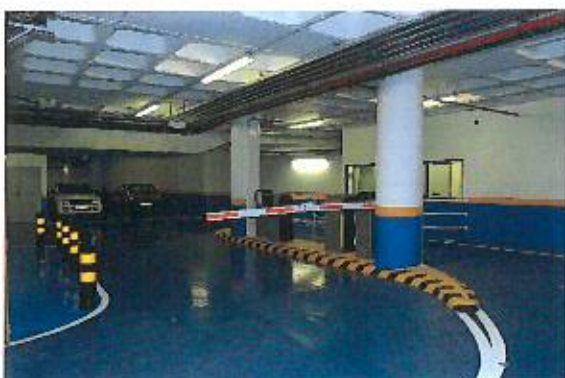
Controlo de acesso de entrada/saída
