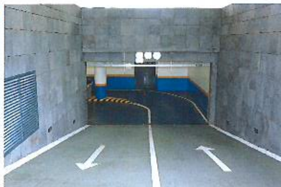
Rampa de acesso do exterior
